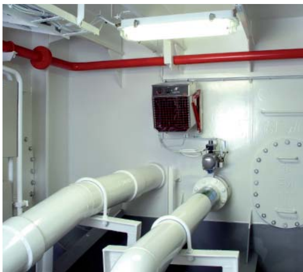
ELEKTRA V byla navržena speciálně tak, aby odolala velkým vibracím, např. lodích nebo těžebních plošinách.
